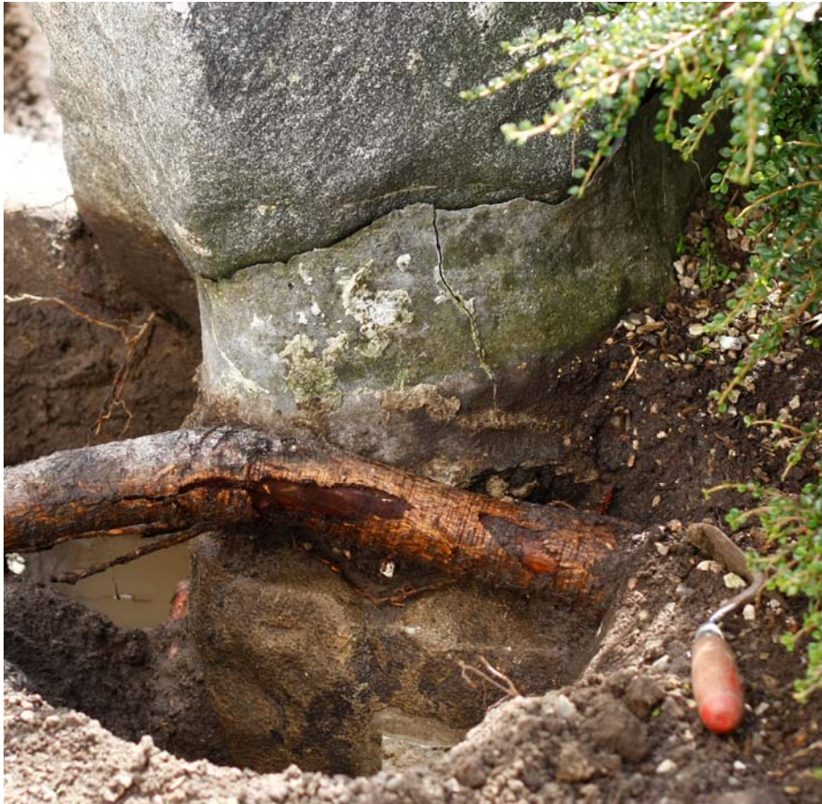
Figur 9. Runestenens opklodsning består af revnet og nedbrudt beton ovenpå en gammel gravsten. Bemærk at betonen har løsnet sig fra runestenen.
