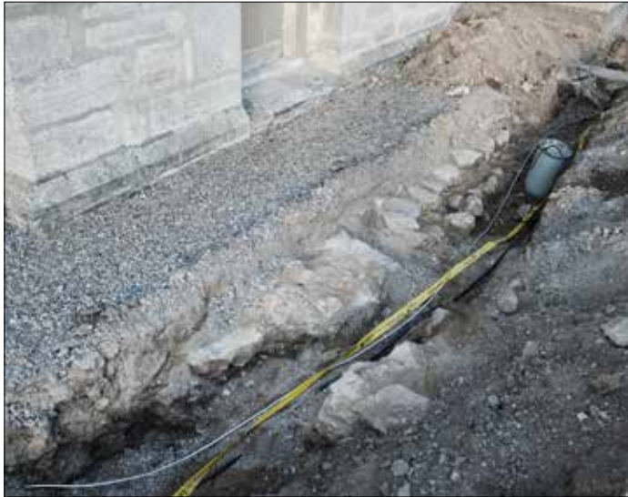
Fig 30 Undersökningsschaktet utanför kapellet och tvärs igenom det rivna vapenhuset. I förgrunden syns vapenhusets västra mur som i ett tidigare skede genombrutits av ett schakt för en dagvattenledning (A200007). I bortre delen av schaktet kan den östra vapenhusmuren anas. Närmast den hitre muren syns två nivåer med sten varav åtminstone den övre kan ha utgjort en golvnivå (A200008). Det cylindriska föremålet på bilden är ett av ljusschakten som det schaktades för. I övre bildkant syns portalen mellan kapellet och det rivna vapenhuset.
