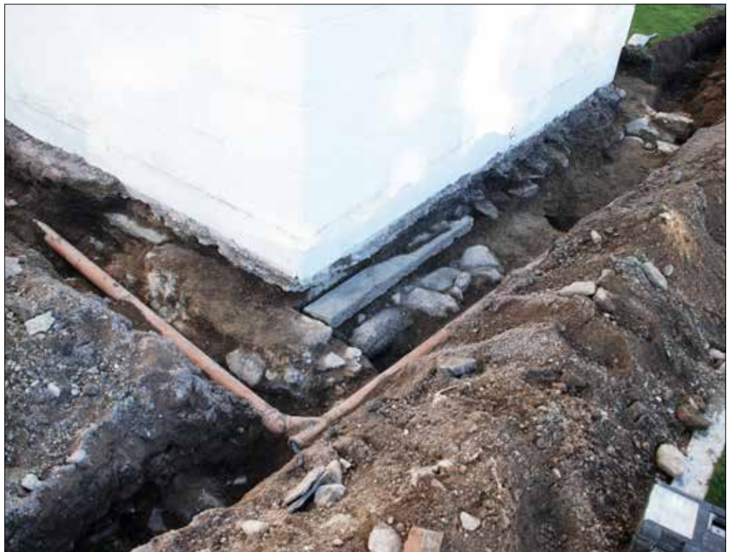
Fig 27. Tornets sydöstra hörn. Direkt under tornhörnet syns det äldre långhusets sydvästra innerhörn.
