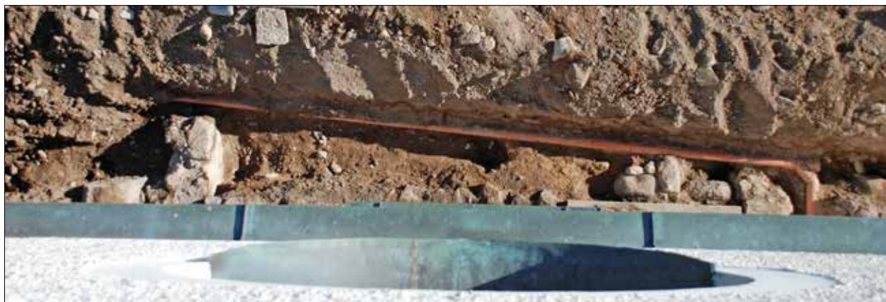
Fig 24. De framgrävda långhusmurarna sedda en bit upp från tornet. På fotot syns tydligt hur nedgrävningen av dagvattenledningen ödelagt stora delar av kyrkmurarna.
