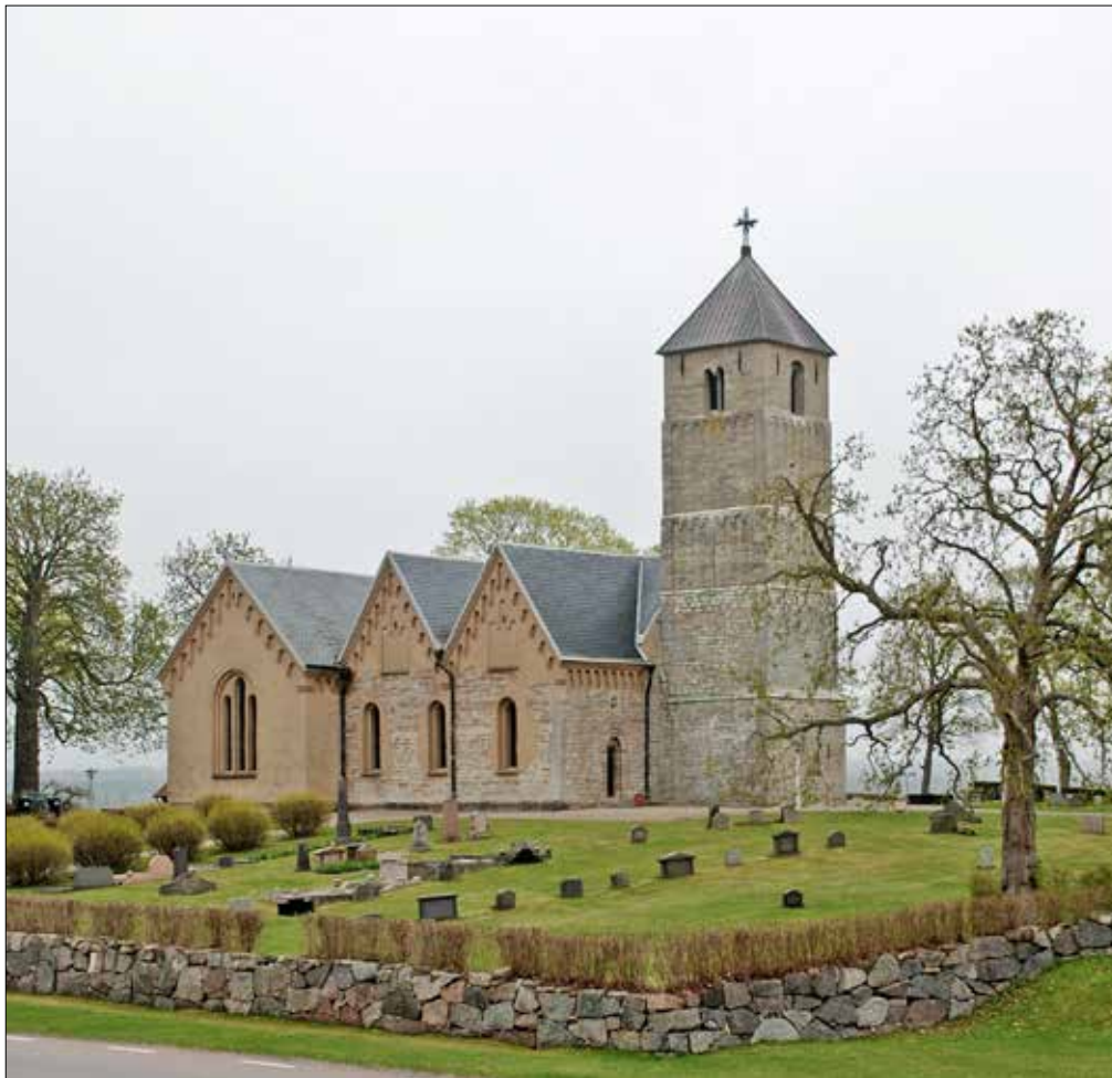
Fig 5. Heda kyrka sedd från nordväst med det norra sidoskeppets portal till vänster om tornet. Framför trappan vid denna portal påträffades ett tidigkristet gravmonument ovan en grav.
