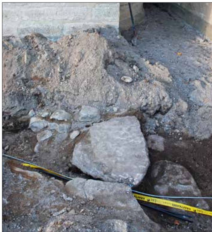
Fig 31. Vapenhusets östra mur (A200006). Ledningen kunde stickas in mellan stenarna i muren som därmed inte behövde grävas bort. Till vänster i övre bildkant syns kapellet södra mur.
