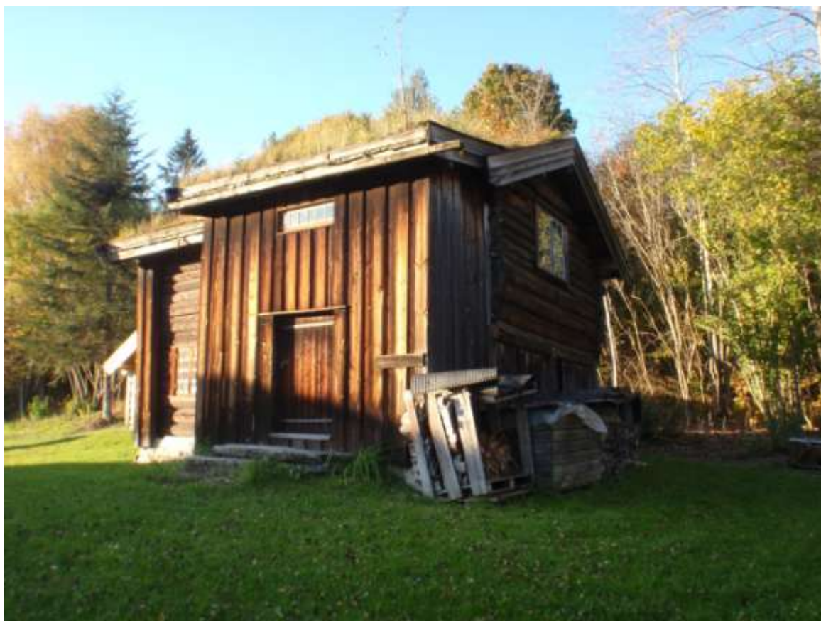
Figur 71. Busnesstugo (ID 86709) med vedstabelen som står innenfor sikringssonen. Tatt mot NV.
