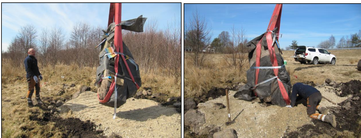
Stenen løftes tilbage, og herefter kan funderingsarbejdet begynde.
